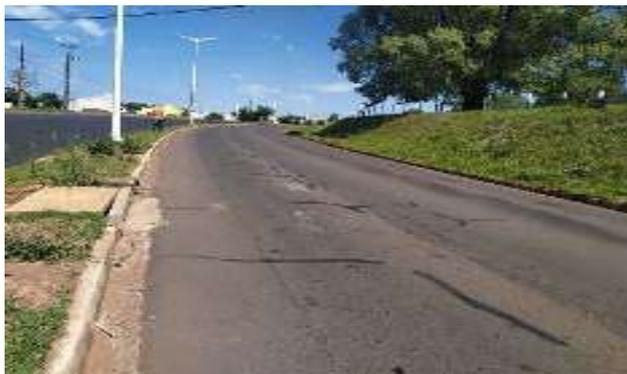
**Afundamento:** Ocorrências esporádicas, causadas por falhas na dosagem e excesso de ligante asfáltico. A Figura 7 ilustra esse defeito.
