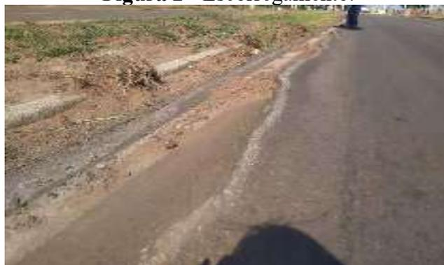
**Remendos:** Conforme mostrado na Figura 3, mal-executados, indicam uso de materiais de baixa qualidade e problemas construtivos.
