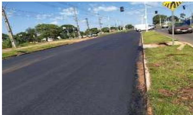
Durante a realização da restauração da Avenida Portugal, realizou ensaios desde a compactação do subleito da via até a execução do revestimento em CBUQ, realizando inspeções e controles de qualidade para verificar se estão de acordo com as normas do DNIT.
