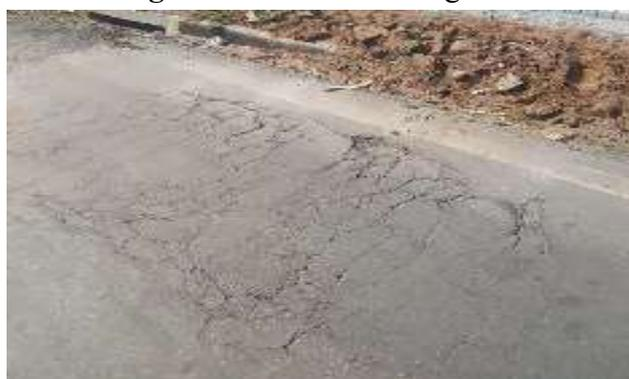
**Panela/buracos:** Conforme mostrado na Figura 5, encontrados em alguns trechos, resultantes do excesso de peso por eixo e degradação das vias.
