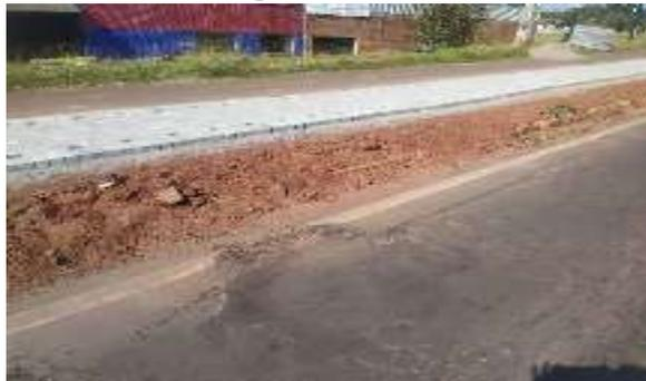
**Trincas interligadas:** Conforme mostrado na Figura 4, comuns ao longo da avenida, causadas pela fadiga do asfalto e fatores como gradientes térmicos e envelhecimento do ligante.
