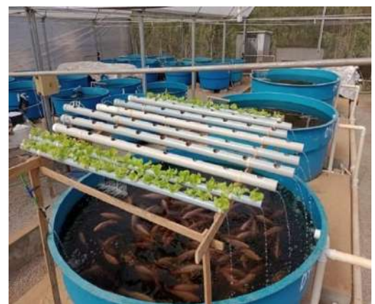
Figura 3- Estrutura NFT com canos de 40 e 75 mm.
