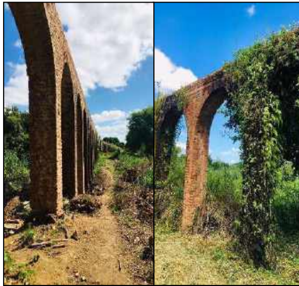
Figura 2 – Aqueduto do Horto Florestal de Juazeiro. Fonte: o autor (2023).
