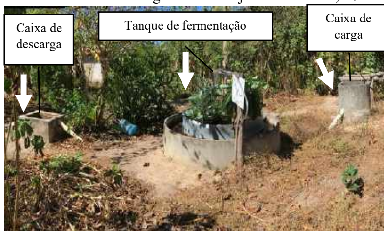
Foto 1 – Componentes básicos de Biodigestor sertanejo Fonte: Autor, 2021.
