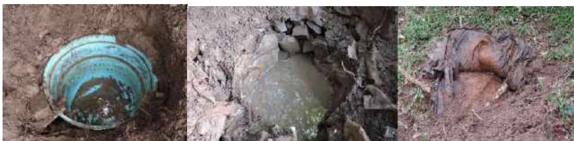
Figura 2 - Sistema de proteção de nascente feito por esvação do solo superficial até o afloramento e introdução de caixa d'água perfurada (adaptação do sistema caxambu).
