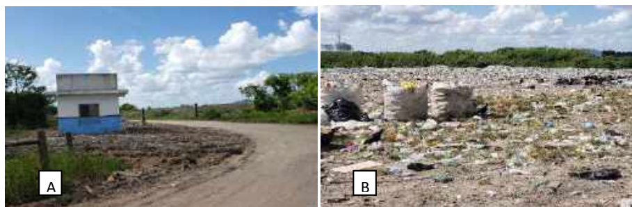
Figura 2 – Em A, vista do acesso ao local de descarte dos resíduos municipais; em B, frentes aleatórias de descarte de RSU, sem cobertura.
